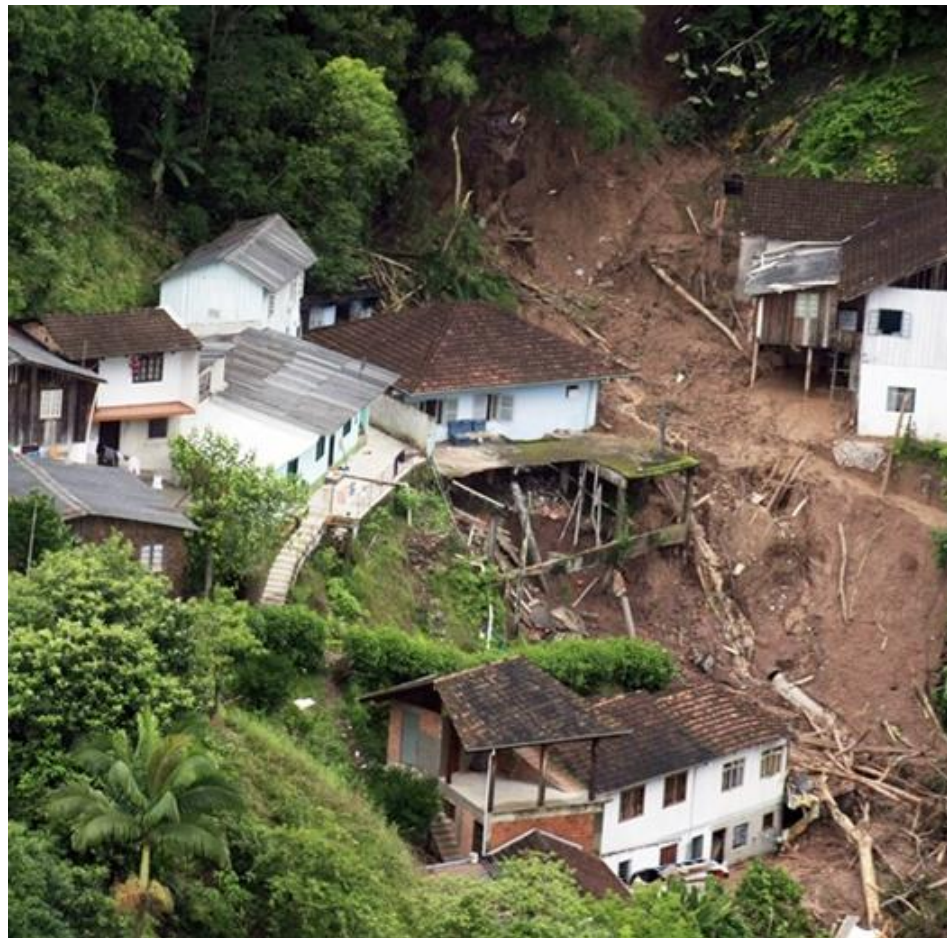
Deslizamento em Blumenau, em novembro de 2008.
